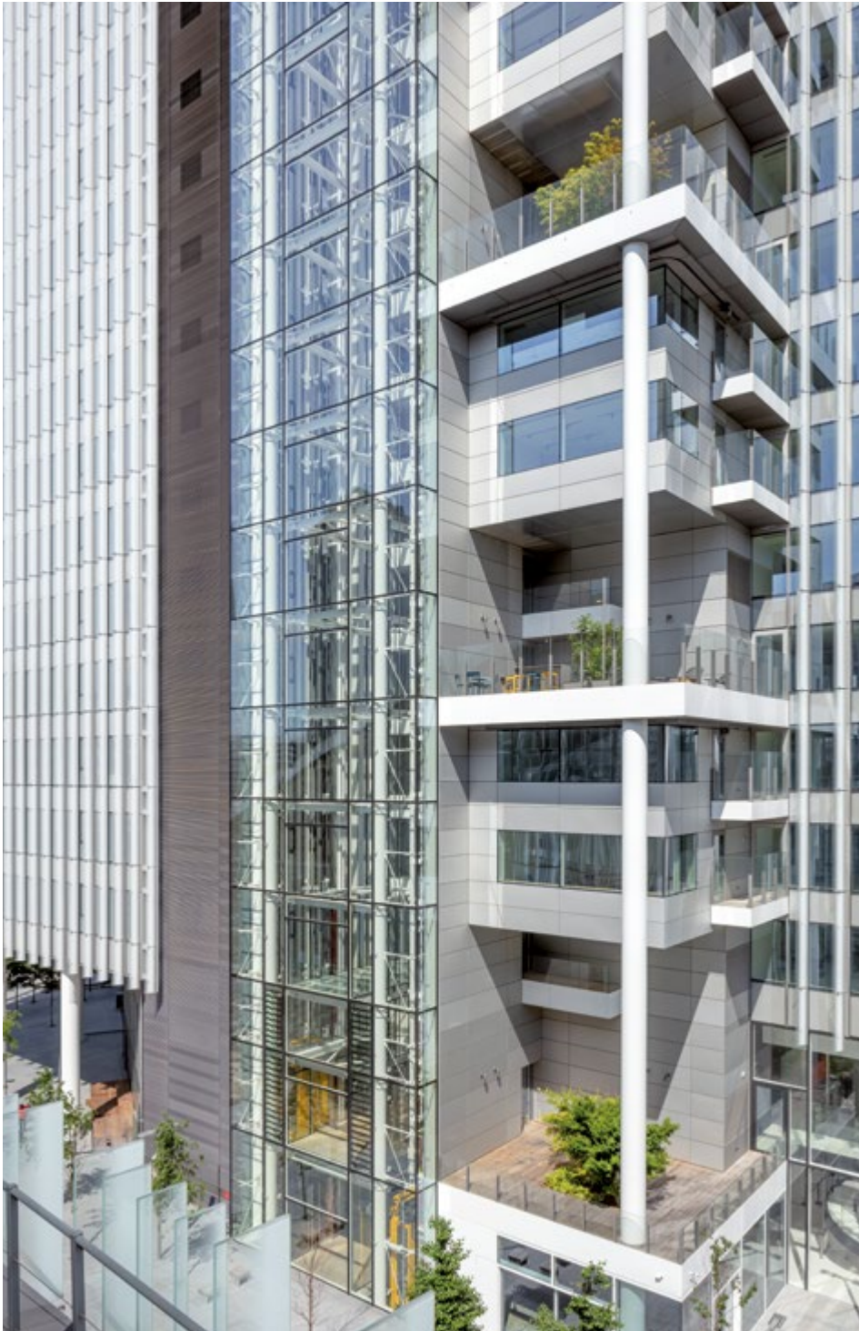
Les ascenseurs de la Tour Trinity créent une animation visuelle depuis l'extérieur, aux couleurs vives qui rappellent les ascenseurs emblématiques de la Tour Eiffel
