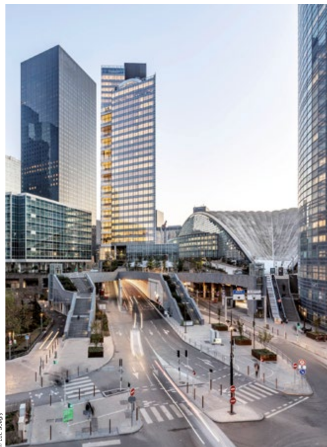
La Tour Trinity a été construite sans foncier, et se tient au-dessus de voies routières et autoroutières
